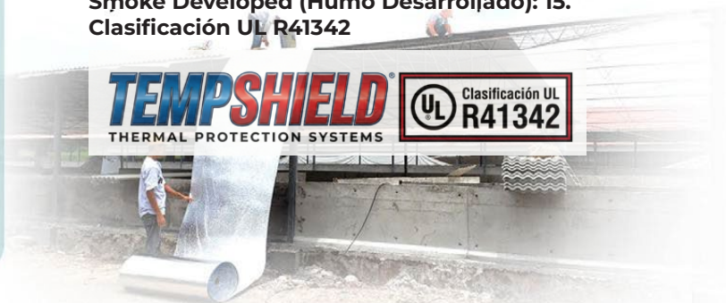
Instalación en caseta porcina
